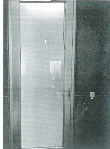
Imagen 2. Puerta de acceso al centro de datos
